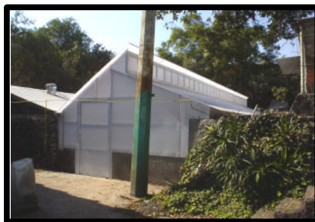
Figura 3. Vista final del invernadero.
